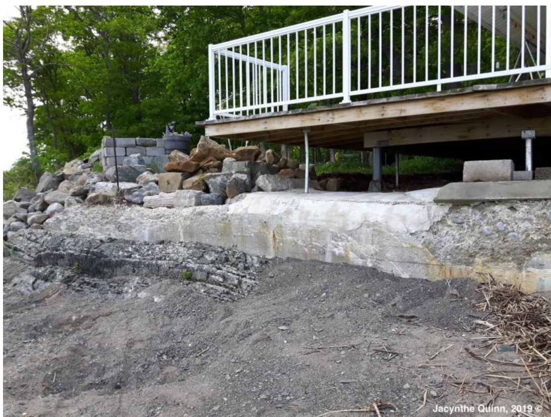
Figure 49 : Un exemple d'une infrastructure soulevée de sa base pour empêcher les dommages d'inondation, Saint-Michel-de-Bellechasse, Québec.
