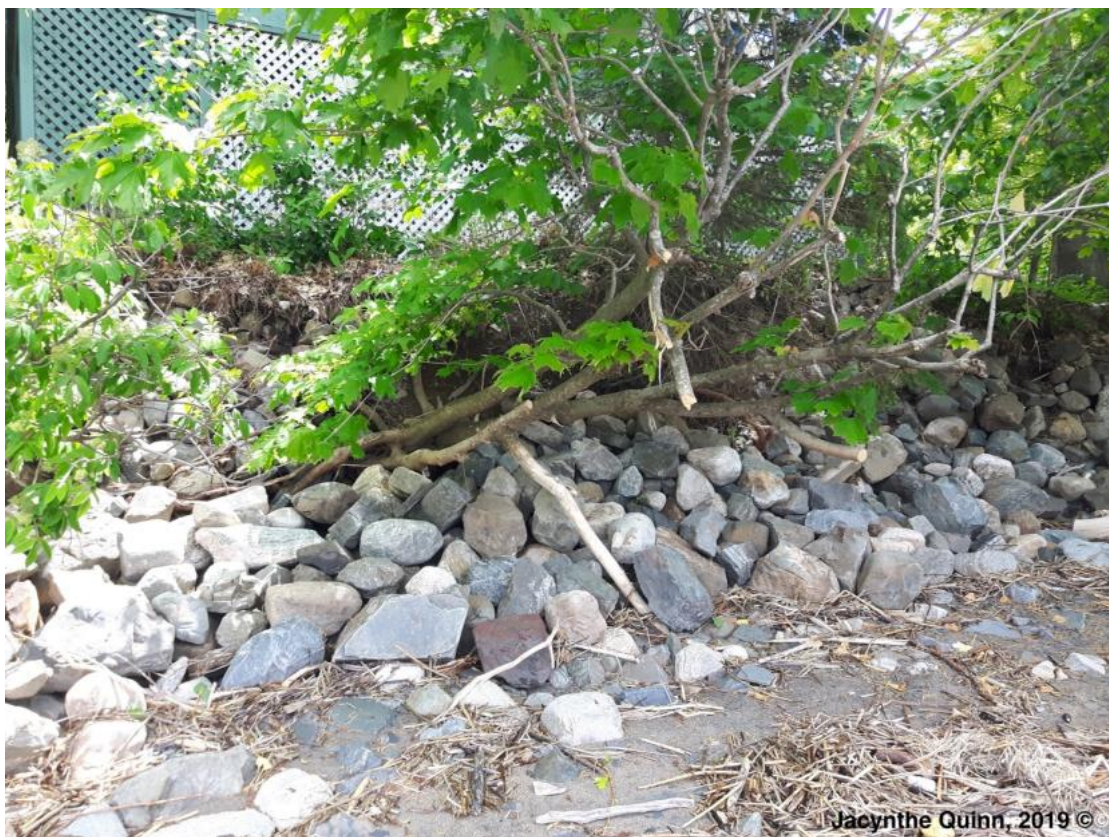
Figure 50 : Un exemple de types de bande riveraine non-réglementaire, soit un enrochement qui n'est pas bien installé et des signes d'érosion, Saint-Michel-de-Bellechasse, Québec.
